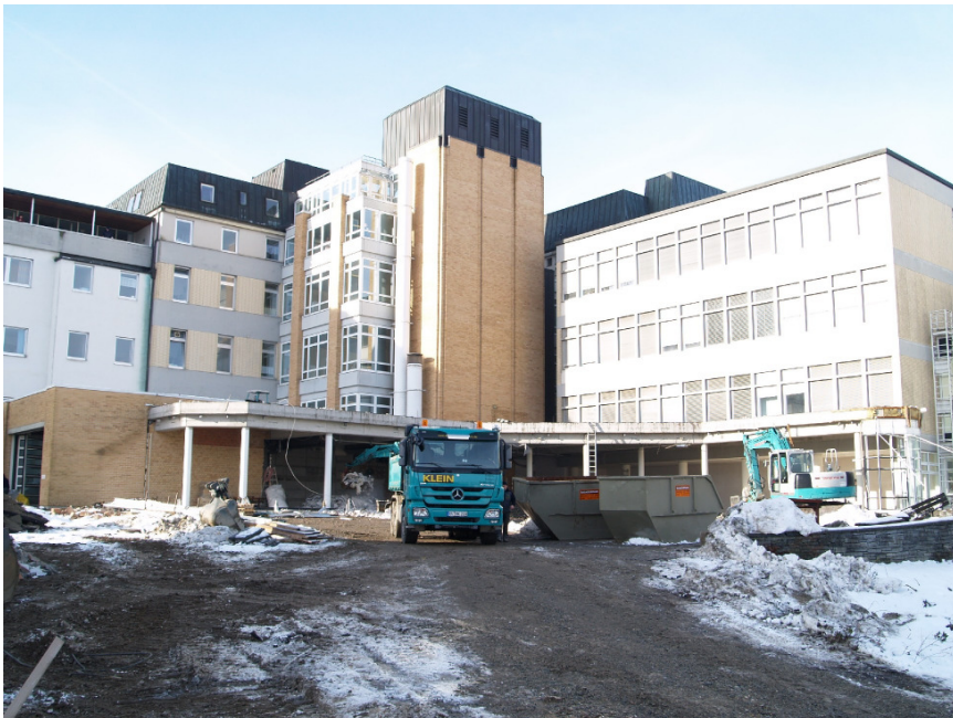
Die Auffahrt, der Brunnen und die Mauern werden abgetragen.
