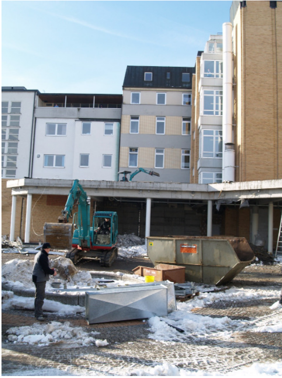
Ein Mini-Bagger räumt das Vordach frei.
