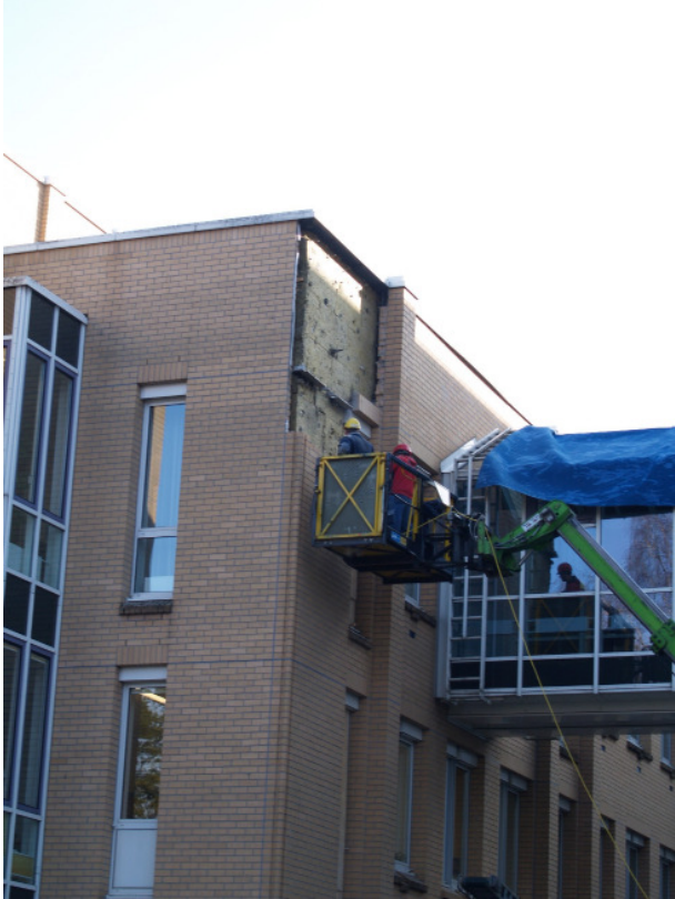
Die Fassade des Funktionsbaus wird abgetragen.
