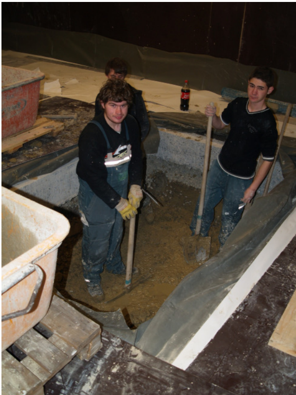
In dieser Grube werden die Pfähle in den Boden gebohrt. Die Baugrube befindet sich im Zentrallager im 2. UG.
