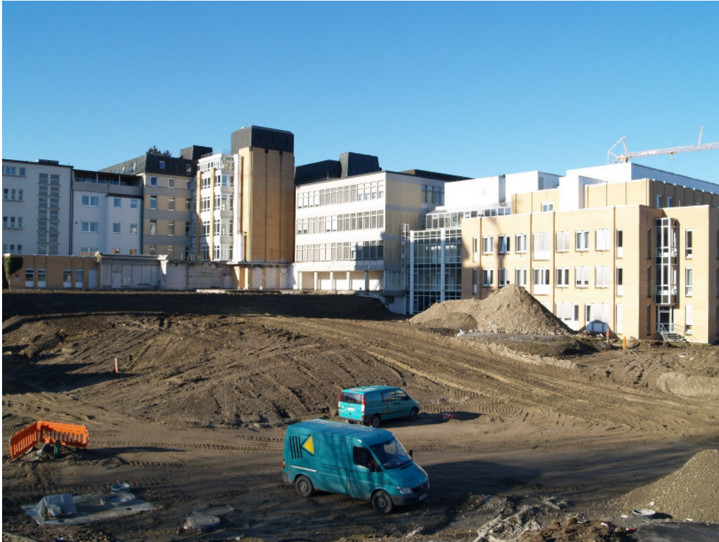
Auf dem Baufeld des Bettenhauses beginnen nächste Woche die Aushubarbeiten.
