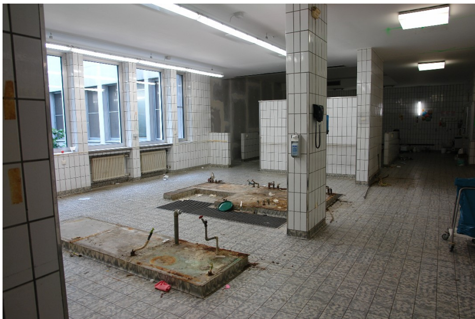
In der ehemaligen Küche werden die Betonsockel sowie die Fliesen an Wänden und Fußboden abgespitzt.
