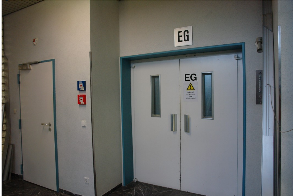
Der nicht mehr benötigte Aufzug wird zurückgebaut.
