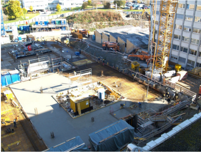
Die Betonmischer stehen in Wartestellung.
