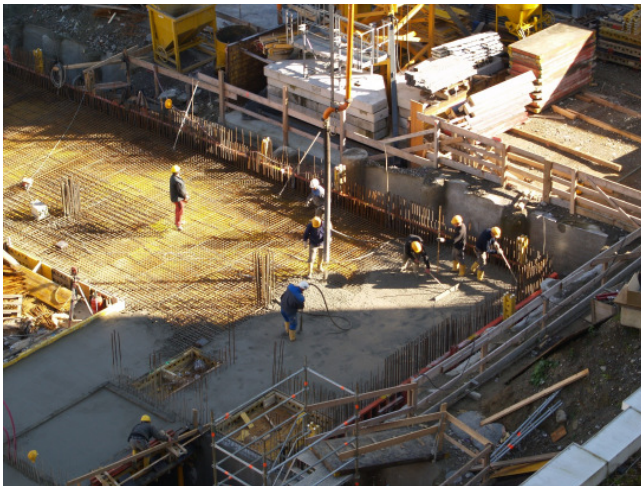
Das Glattstreichen des Betons erfolgt von Hand.
