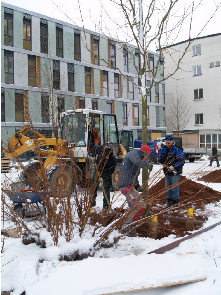
50 In Handarbeit werden die Bäume ausgerichtet. Die gelben Plastikröhren dienen der Drainage und der Belüftung der Wurzeln.
