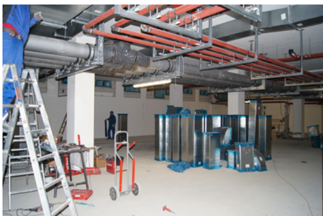
In den Kellergeschossen des Bettenhauses werden die ersten Installationen montiert.
