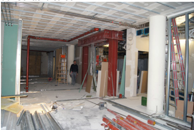
Der Zweier-Aufzug ist mittlerweile demontiert, der Schacht ist leer.
