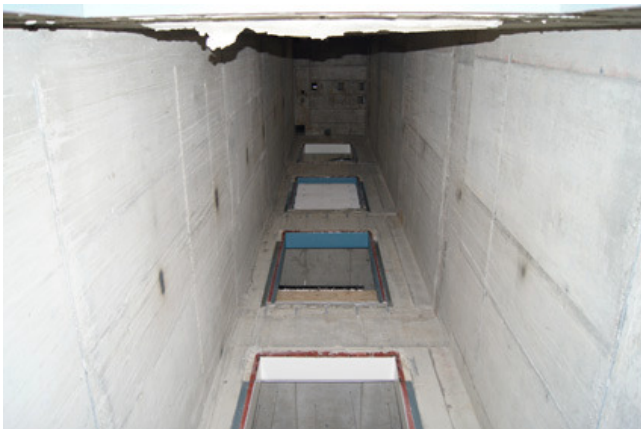
Der Zweier-Aufzug ist mittlerweile demontiert, der Schacht ist leer.
