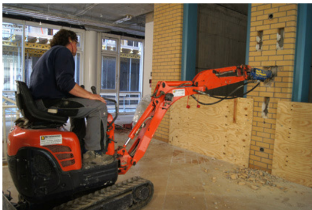
Ein Abbruchhammer meißelt an der Wand des Aufzugschachtes.
