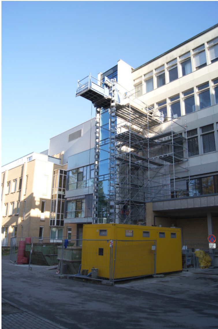
Über dieses Gerüst im Wirtschaftshof erfolgt der Zugang zur Baumaßnahme B4 im zweiten Obergeschoss.
