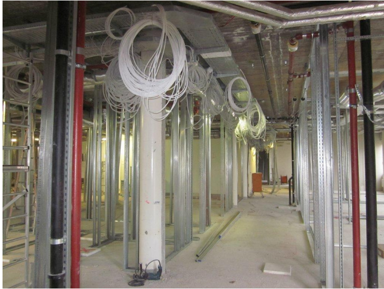
Die zukünftigen Räume der Radiologie sind mittlerweile erkennbar.
