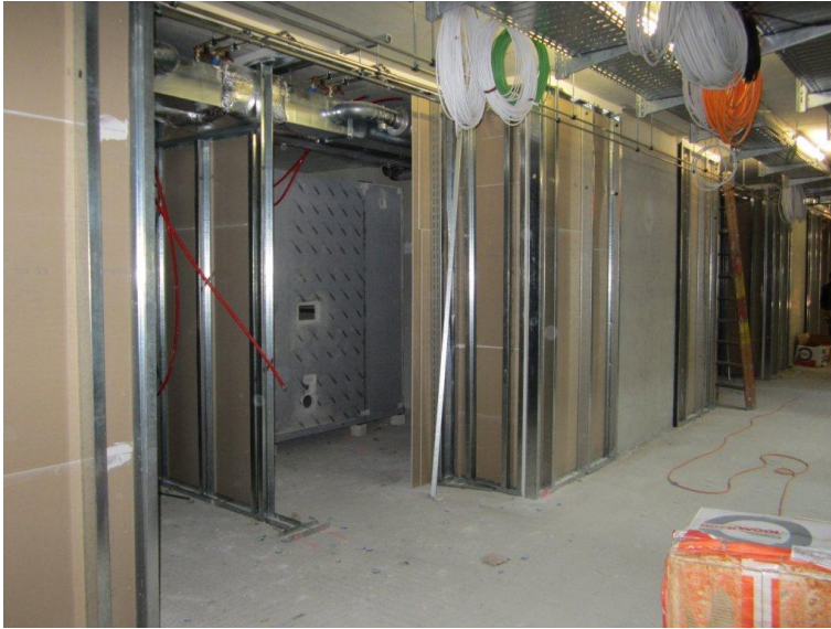
30 Die Patientenzimmer mit den vorgefertigten Nasszellen nehmen Gestalt an.
