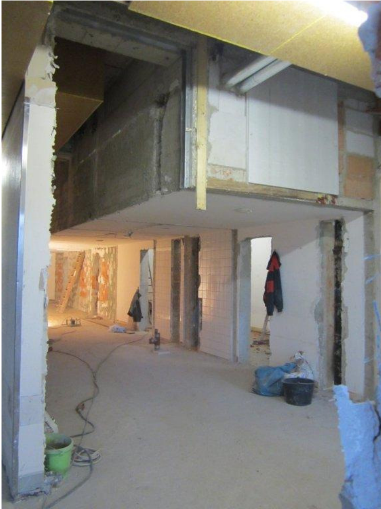
Diese 20 Tonnen schwere Decke wird abgebrochen.
