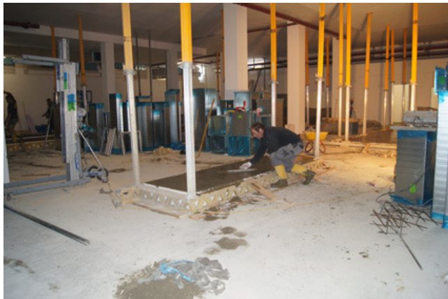
Die Sockel für die technischen Anlagen werden betoniert. Die einzelnen Elemente des Lüftungssystems stehen zur Montage bereit.
